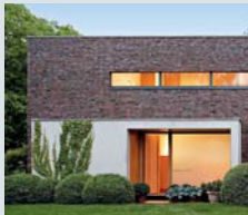
Einfamilienhaus Kevelaer, Deutschland
