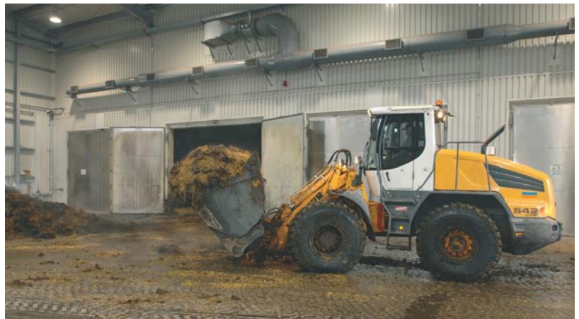
Befüllung der Fermenter: durch das patentierte Verfahren wird hochwertiges Biogas gewonnen
